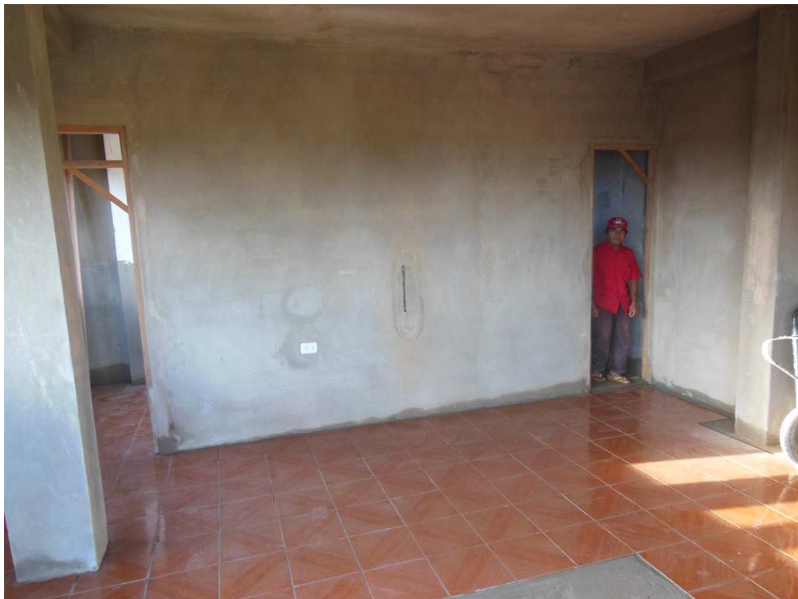
Die Unterkunft auf dem Weg zur Fertigstellung. Im Bild ist ein Handwerker zu sehen.
